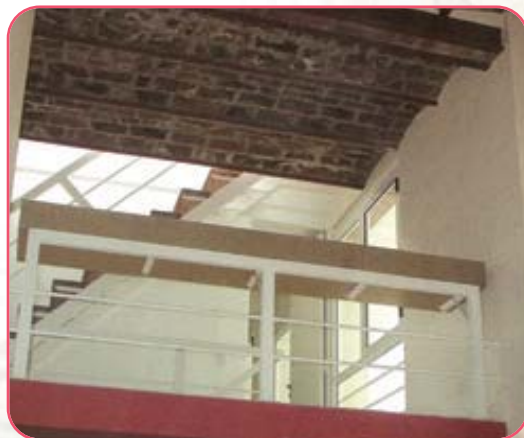
Imagen 5.17. Techo con viguetas de acero y ladrillos
