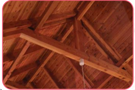
Imagen 5.16b. Detalle de la estructura del techo
