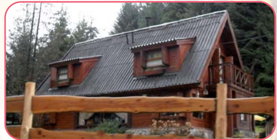
Imagen 5.27. Vivienda unifamiliar con estructura de madera
