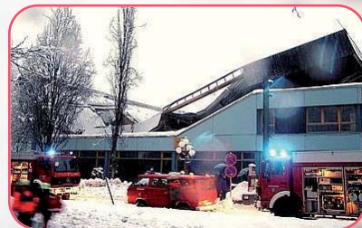
Imagen 5.8. Caída del techo en Alemania. (2 de enero de 2006)
