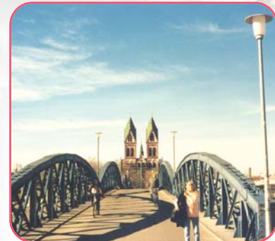
Imagen 5.55. Puente en la ciudad de Fribourg - República Federal de Alemania
