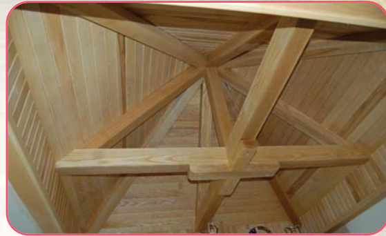
Imagen 5.29. Estructura de madera de un techo a dos aguas
