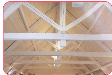
Imagen 5.26. Un edificio con estructura de techo de madera
