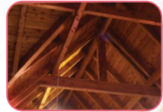
Imagen 5.15. Estructura del techo de madera
