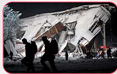
Imagen 5.7. Caída del techo por efecto de la nieve en Bad Reichenhall - República Federal de Alemania (2 de enero de 2006)
