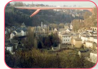
Imagen 5.4 Puente que cruza uno de los valles de la ciudad de Luxemburgo (Gran Ducado de Luxemburgo)
