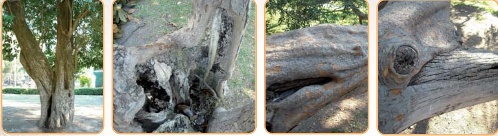
Imagen 4.5. Tronco. Pudriciones, grietas y fisuras, deformaciones
