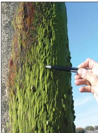
**Figura 1.8.** Biodeterioro de una estructura de hornigón.
