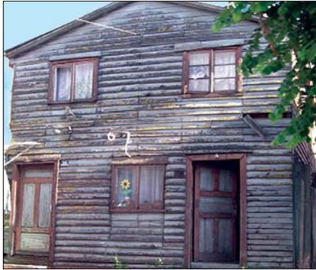
**Figura 1.4.** Degradación de una vivienda de madera por efecto de la exposición a la intemperie sin una adecuada protección. Osorno, Chile.
