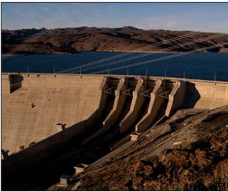
**Figura 4.40.** Represa hidroeléctrica. Acumulación artificial de agua que ejerce presión sobre la formación rocosa y puede producir fisuras en la misma.
