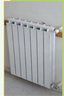
Figura 5.6. Ejemplo de un radiador por el que circula agua caliente.
