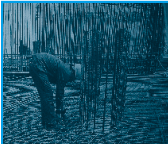
Operarios colocando la armadura de una estructura de hormigón armado; FEMATEC 2005
