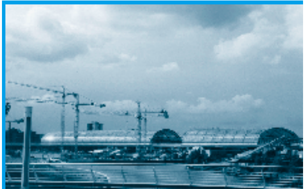
Vista de la construcción de la Berlin Hauptbahnhof, Berlín
