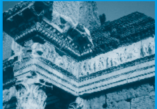
Detalle de columna
