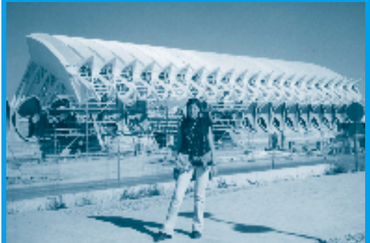
El museo en la etapa constructiva
