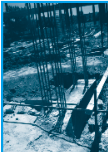
En la obra: armado de columnas; armadura longitudinal y estribos
