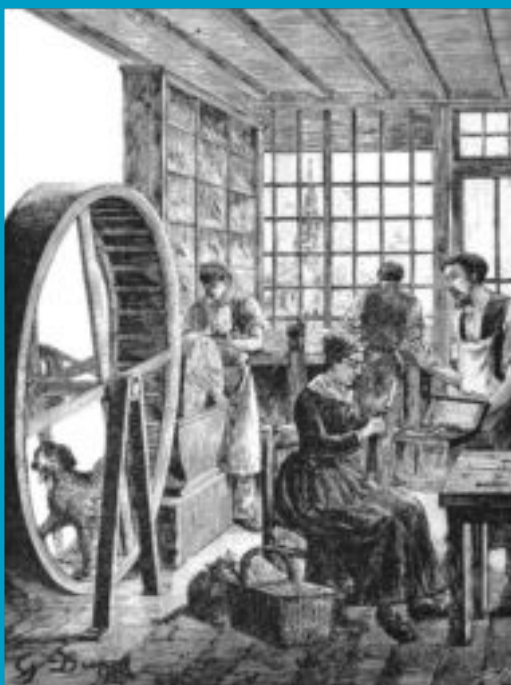
Perro suministrando energía mecánica a una piedra de afilar cuchillos; dibujo de 1860
