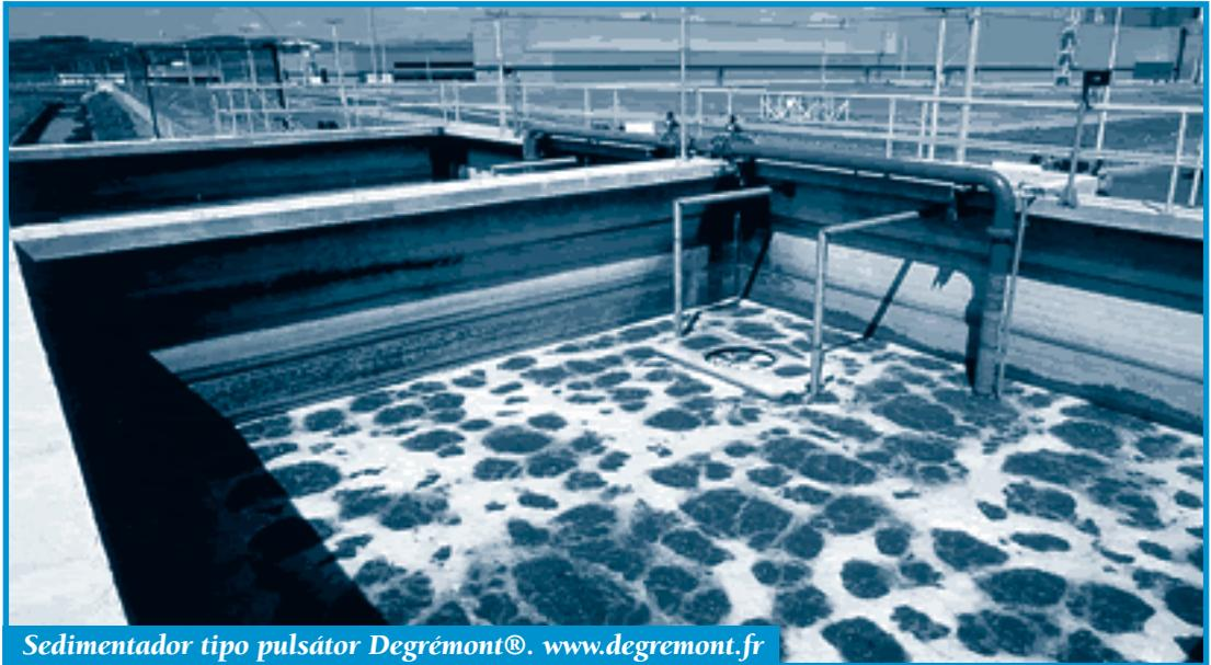
**Sedimentador tipo pulsátor Degrémont®. [www.degreumont.fr](http://www.degreumont.fr)**
